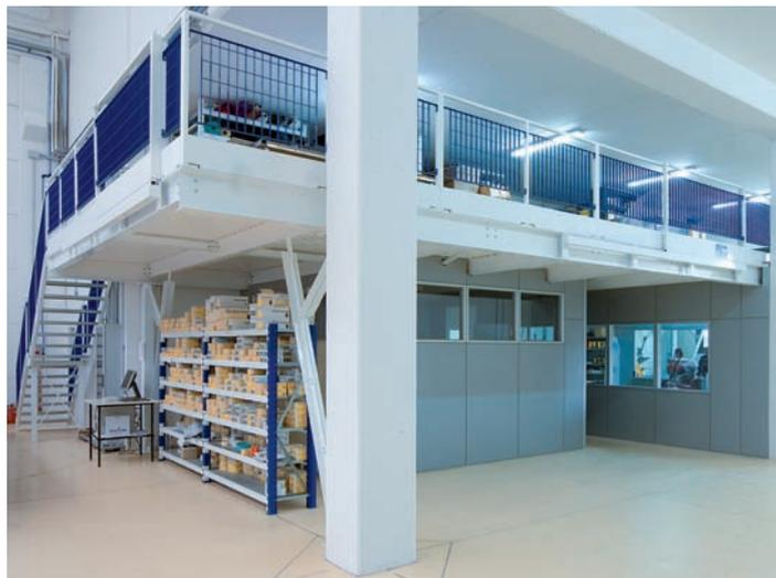
Grazie a specifiche strutture appositamente realizzate e particolarmente robuste, possono essere costruiti soppalchi capaci di sopportare carichi considerevoli. La struttura a telaio composta da montanti di sostegno e travature portanti e secondarie crea un vero e proprio piano rialzato e per la propria conformazione dà la possibilità di avere ampi spazi liberi a terra.
